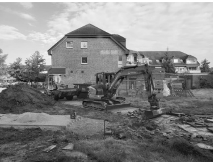
Der Abriss mit Bagger und schwerem Gerät
